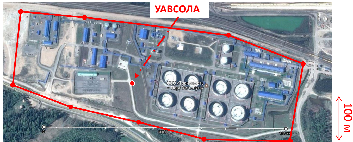
Объект ООО «Транснефть Порт Усть-Луга»,
